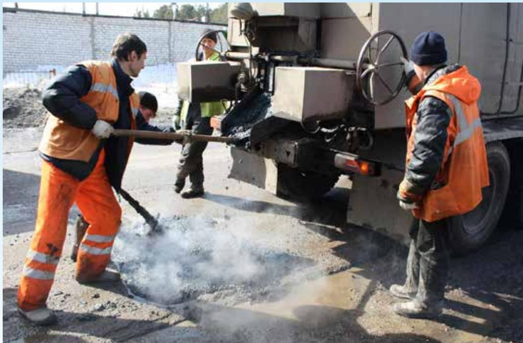
бот. Данный вид ремонта включает в себя устранение трещин, выбоин, просадок, восстановление шероховатости и ровности покрытия, устройство слоев износа. При этом главная цель – обеспечить на дороге безопасное комфортное движение автотранспорта с разрешенной правилами дорожного движения скоростью.
