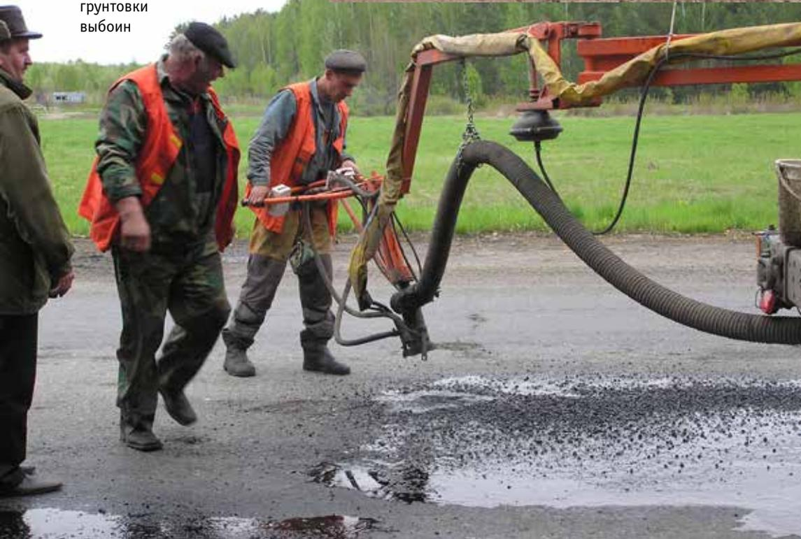
– система, позволяющая промывать и продувать трубопроводы от остатков эмульсии, закачивать эмульсию в бак с использованием собственного диафрагменного насоса, промывать водой дно ямы от глины и грязи под давлением до 8 атм, смачивать и промывать щебень перед подачей его в трубопровод для улучшения адгезии;
